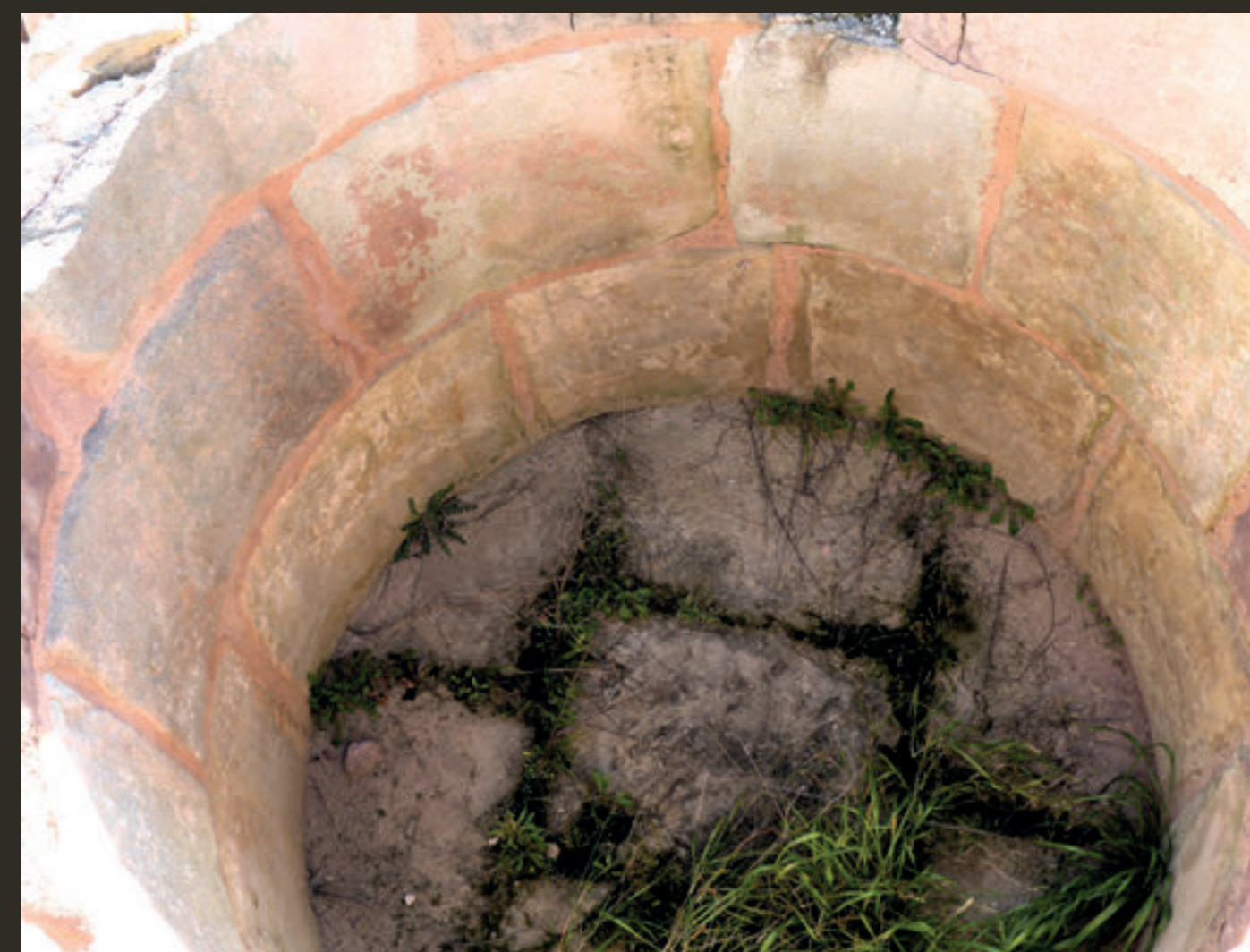
Intérieur de la cuve
